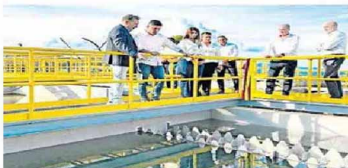
Planta de potabilización de Aqualia.
