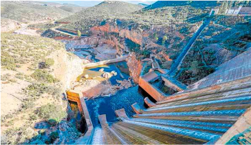
Vista aérea de la presa de Forata. IRENE MARSILLA
