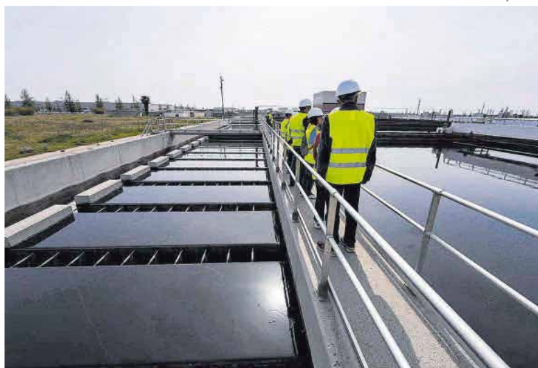
Depuradora de El Prat de Llobregat, el pasado marzo.
